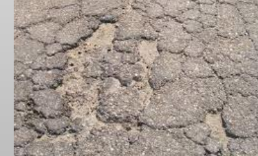
Gevşek malzemelerin sağlam yüzeye ulaşınca kadar çıkarılması gerekir.
