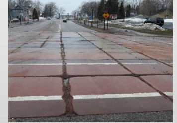
Doğru uygulama için döşemelerin stabilize edilmesi gerekir.
