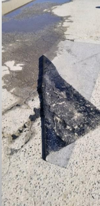
Çatlaklar doldurulmaz ise ARP boşlukları doldurmaz
