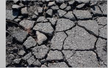
Gevşek malzemelerin sağlam yüzeye ulaşınca kadar çıkarılması gerekir.
