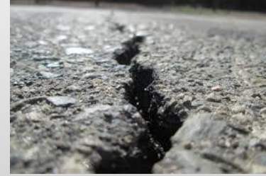
Çatlaklar doldurulmaz ise ARP boşlukları doldurmaz
